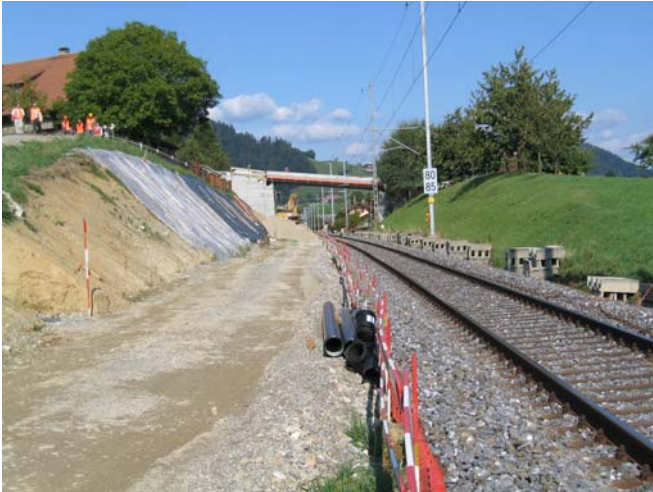
Fertiger Bauwerksaushub, die Böschungen werden temporär mit Geotextilien gegen Erosion geschützt.
