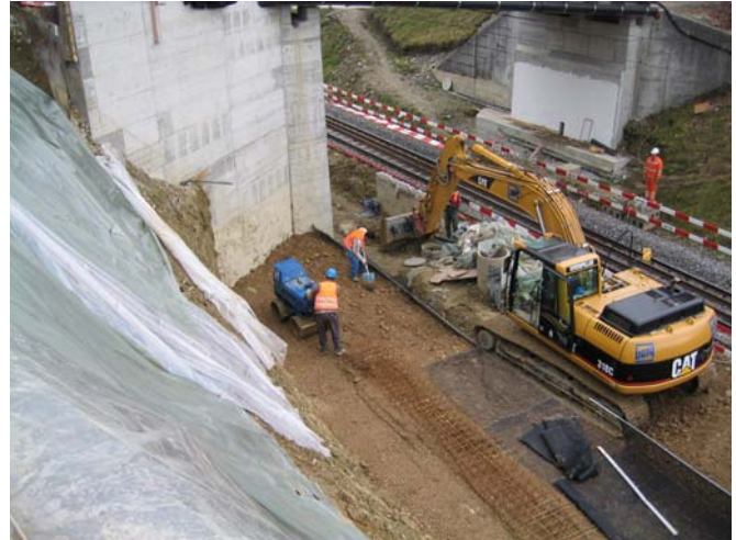
Anschluss an die Eisenbahnquerung, die spätere zweite Bahntrasse wird als Arbeitsplattform bzw. Baustraße genutzt.
