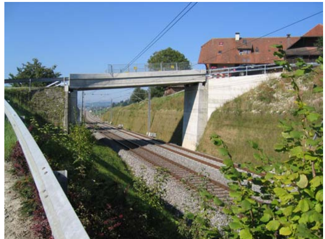
Das fertige, erfolgreich begrünte Bauwerk ca. 2 Jahre nach der Fertigstellung.
